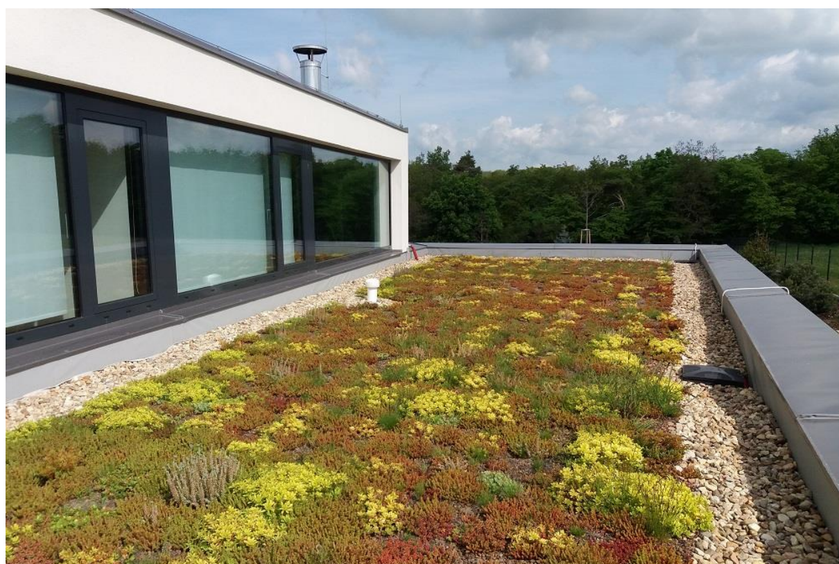
Fig. 4.5.2. Green roof in Hostětín.
