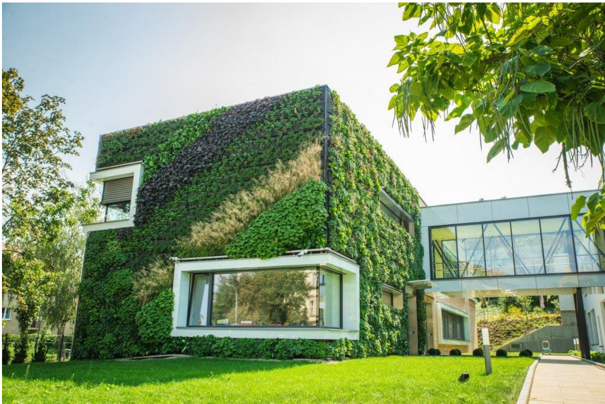
Fig. 4.5.3. Example of a green wall in Hostětín.
