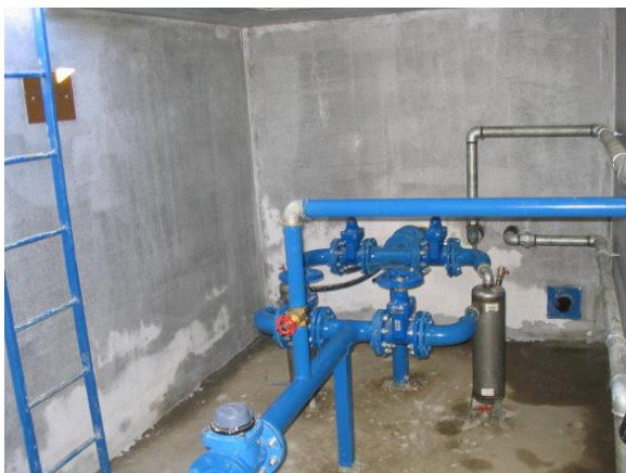
Fig. 16.3. Hőt szolgáltató talajvízkút.
