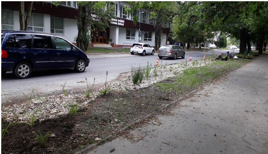
Fig. 9.5. The complete rain garden.
