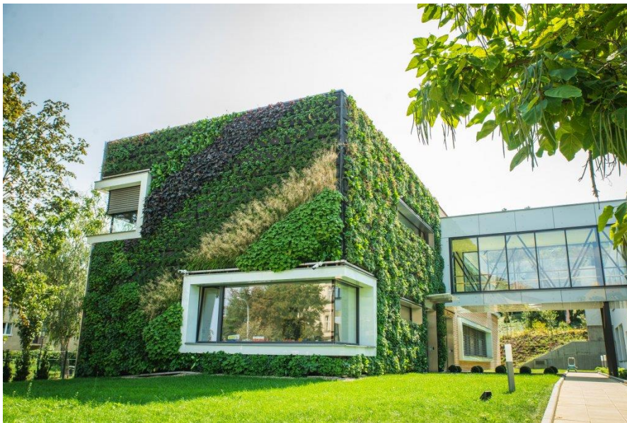
Fig. 3.4. Example of a green wall in Hostětín.
