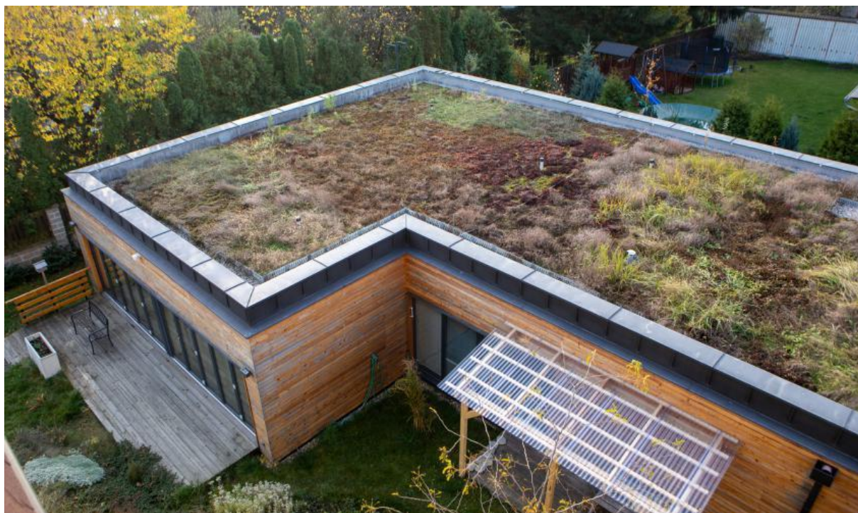
Fig. 16.3. Rozsáhlá zelená střecha.
