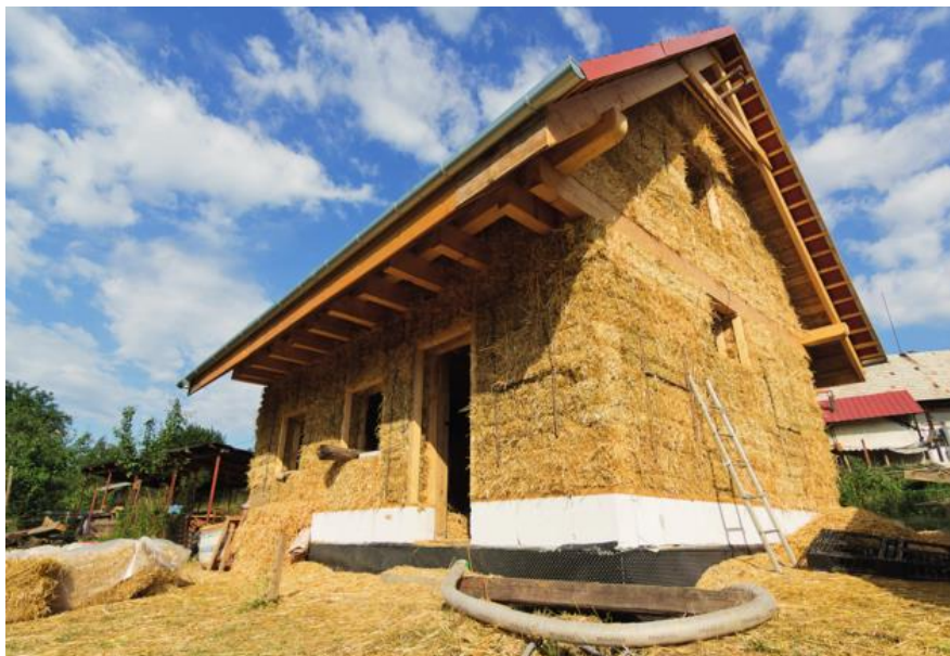
Fig. 19.2. Slaměný dům jako pasivní stavba
