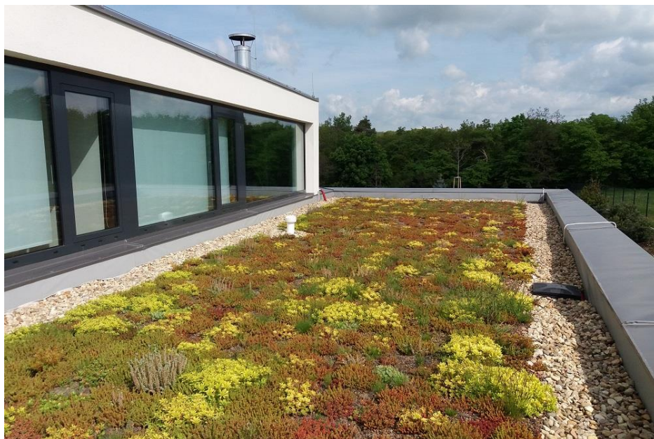
Fig. 3.2. Green roof in Hostětín.
