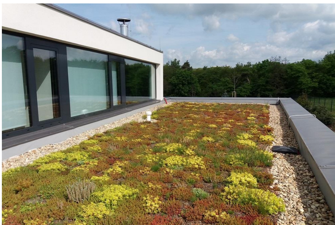
Fig. 13.2. Zelená střecha v Hostětíně.
